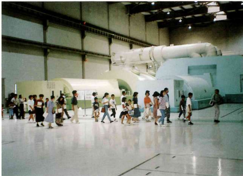
電源開発松浦火力発電所見学会
